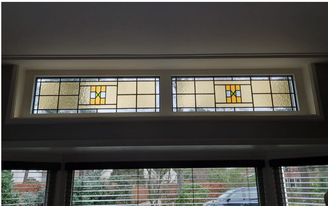
Glas in lood panelen als voorzetramen gemonteerd aan de binnenzijde.
